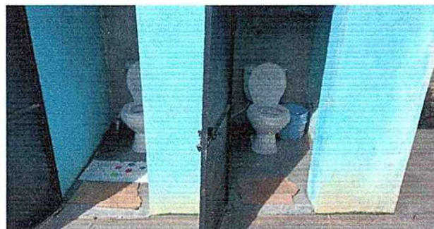
Foto 2: Se hizo la reparacion de dos sanitarios
