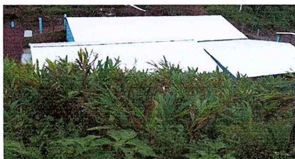
Foto 5: El entechado terminado.
